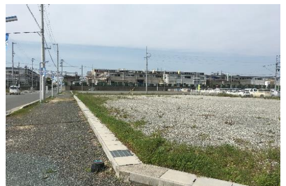
北口工事現場から(都) 磐田袋井線方面を見る
