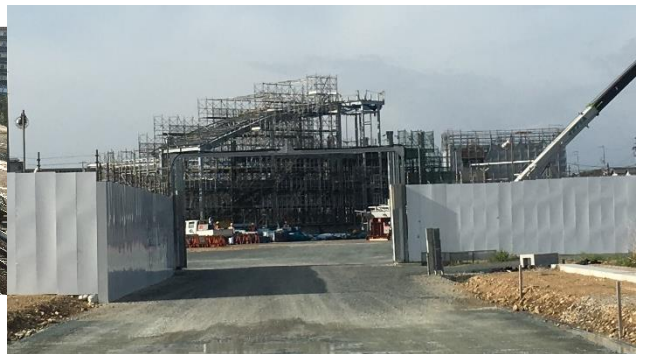
新駅南口線から南口正面工事現場を見る
