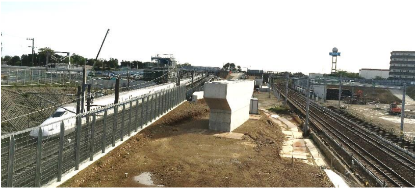
神明中北側橋梁から見る駅舎工事現場・道路橋げた工事
