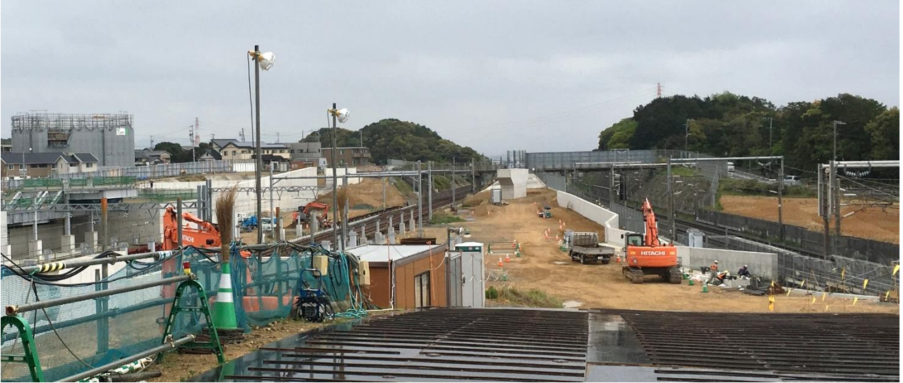
西側坊中橋付近から工事現場を見る
